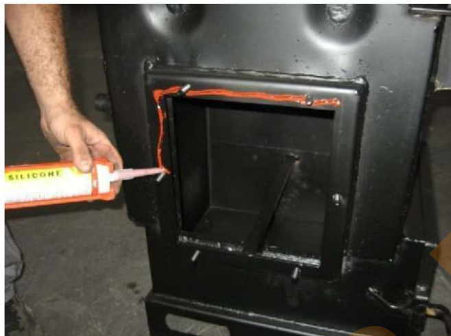
Рисунок 7. Нанесение жаростойкого силикона перед установкой прокладки.
