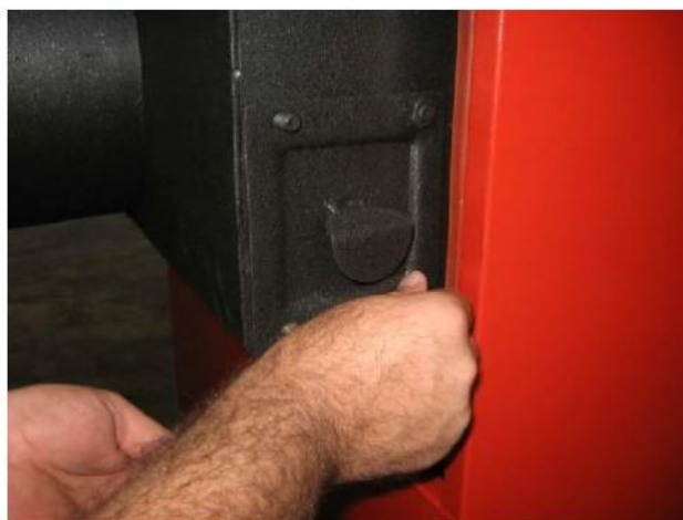
Рисунок 15. Снятие заглушки для чистки адаптера дыма
