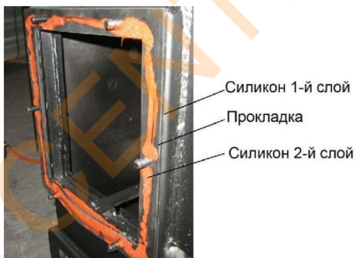
Рисунок 8. – Установка прокладки на силикон и нанесение второго слоя.
