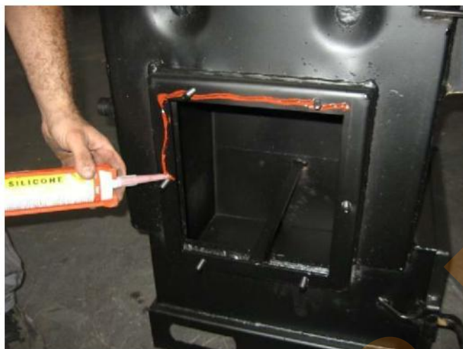
Рисунок 7. Нанесение жаростойкого силикона перед установкой прокладки.
