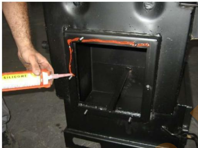
Рисунок 7. Нанесение жаростойкого силикона перед установкой прокладки.
