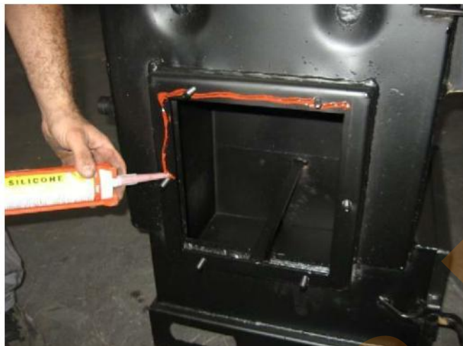
Рисунок 7. Нанесение жаростойкого силикона перед установкой прокладки.
