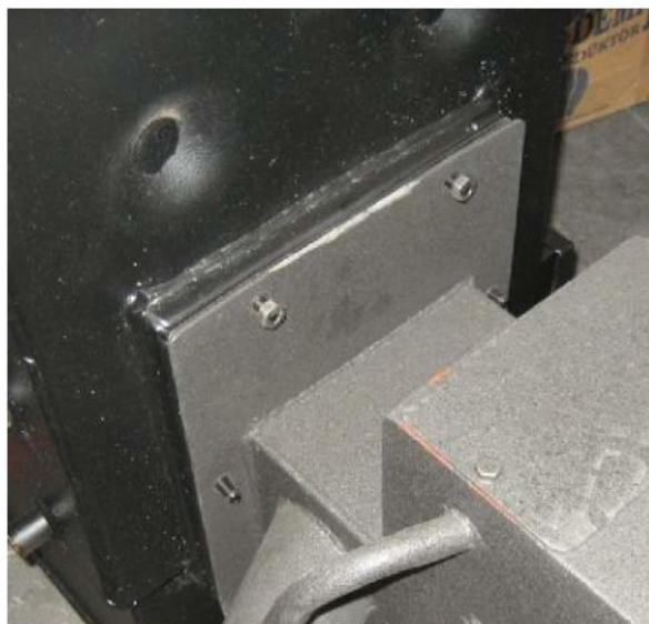
Рисунок 9. Установленный на котле корпус шнековой подачи.
