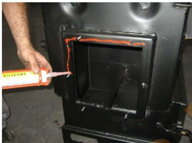
Рисунок 7. Нанесение жаростойкого силикона перед установкой прокладки.
